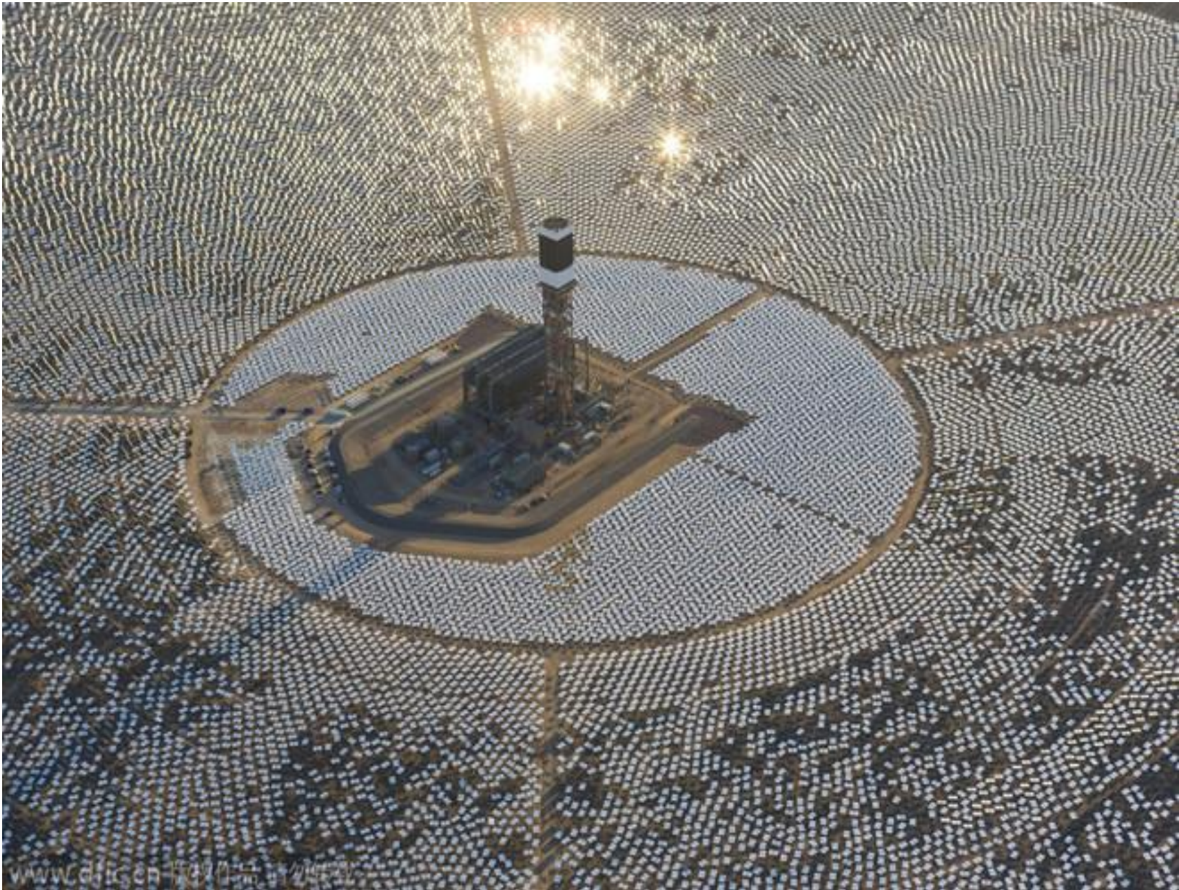
Với diện tích khổng lồ, nhà máy này có thể sản xuất gần 400 megawatt điện một năm. Dự án xây dựng nhà máy do công ty năng lượng Bright Source, NRG và công ty Google phát triển.
